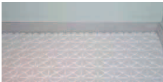
4.-COLOCACIÓN PLACA BASE
