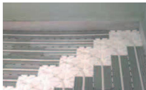
7.-COLOCACIÓN DE TUBO
