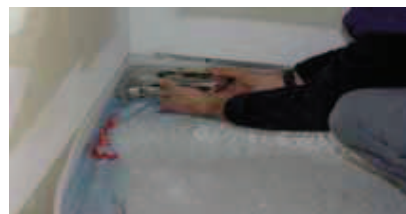
3.- COLOCACIÓN DE TIRA PERIMETRAL
