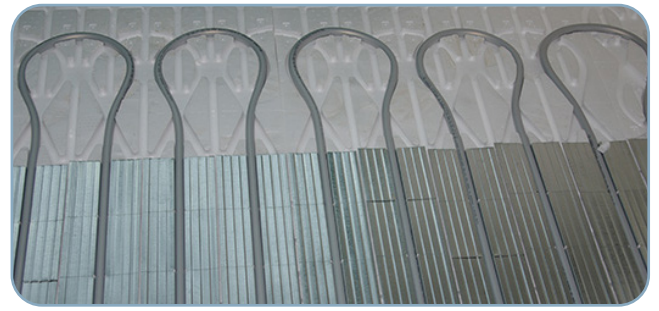
7.- Una vez hecha la primera espiral, hacer la espiral de retorno en paralelo
