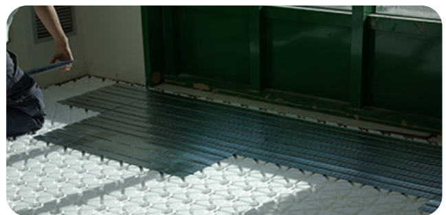
4.- Colocación difusores en las zonas rectas de elemento base.
