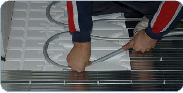
6.- Colocación del tubo en las curvas
