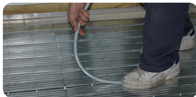
5.- Colocación del tubo en las zonas rectas
