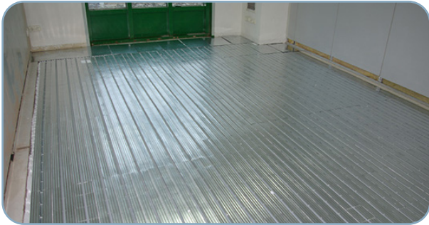
8.- Colocar las placas sobre todas las curvas.
