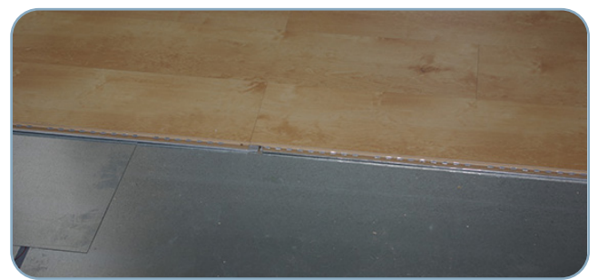
11.- Procedimiento de solado.
