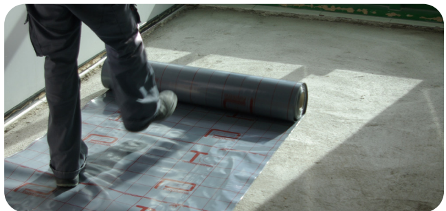
2.- Colocación hoja de PE
