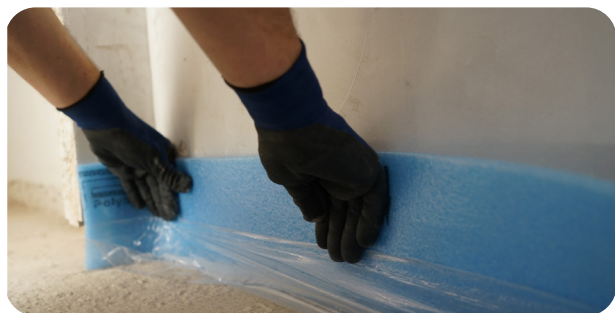
3.- Colocación de tira perimetral
