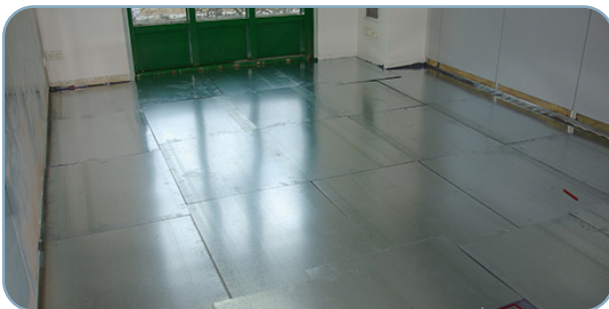
10.- Colocar doble las placas por toda la superficie de la instalación. Se deben colocar contrapeadas para un correcto reparto de cargas.
