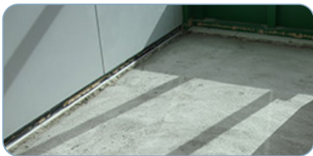
1.- Preparación de Solera
