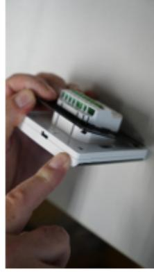
1. Pulsar con el destornillador para separar la base del termostato
