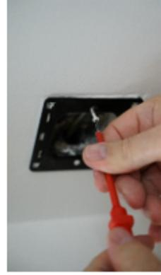
2. Colocar la placa base sobre la caja de mecanismos
