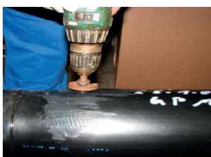
13. Reparar los orificios con una broca.
