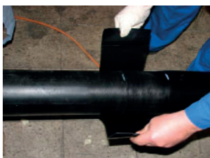
9. Colocar la cinta autoadhesiva sobre la unión del manguito con el tubo
