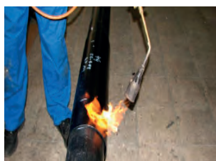
6. Contraer los extremos de la camisa calentando la misma con una antorcha.
