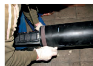
4. Limpiar y lijar el área donde va a ir la camisa.
