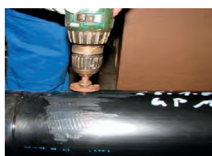
13. Reparar los orificios con una broca.
