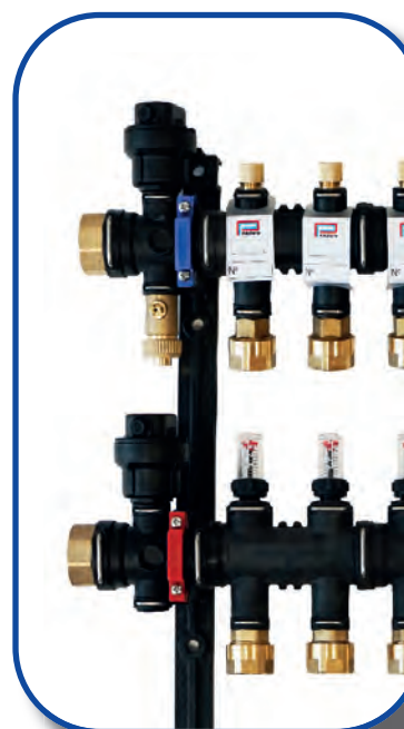
COLOCACIÓN DEL SOPORTE SOBRE LOS TERMINALES
