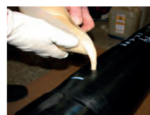
12. Introducir la mezcla de poliuretano por los orificios en la camisa.
