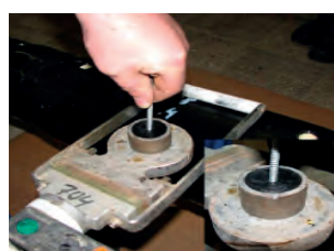
14. Con la máquina de termofusión soldar los tapones definitivos para que la unión quede totalmente estanca.
