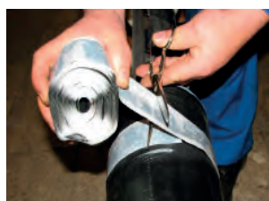
5. Instalar la cinta elástica en ambos lados del área de colocación de la camisa.
