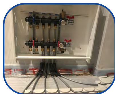
5.- Colocación tubo de los distintos circuitos.
