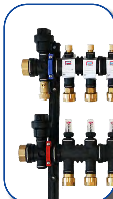
COLOCACIÓN DEL SOPORTE SOBRE LOS TERMINALES
