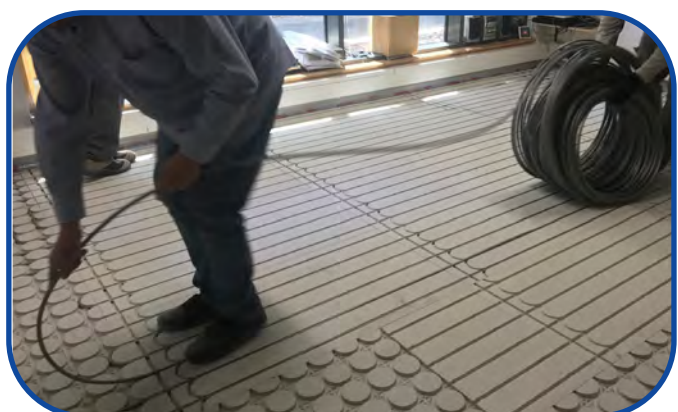
5.- Colocación tubo de los distintos circuitos.
