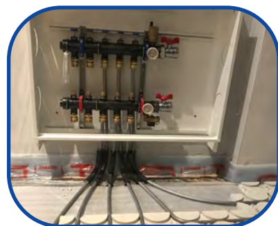
5.- Colocación tubo de los distintos circuitos.
