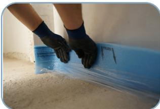
La tira perimetral sirve para evitar que el calor se transmita a los parámetros verticales y permitir la dilatación de la placa de mortero.
