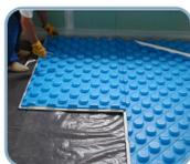
La fijación entre elementos se hace mediante machihembrado. En forjados irregulares se pueden utilizar bridas que unen una placa con la contigua.
