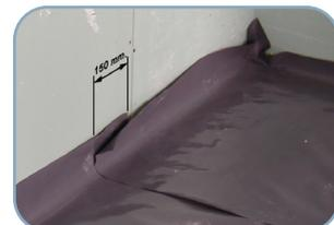
La colocación de esta lámina de polietileno, se efectúa desenrollando, cortando y desplegando dicha lámina. Teniendo en cuenta, que debe solapar en los cerramientos verticales y con sucesivas láminas (aprox. 15 cm.).
