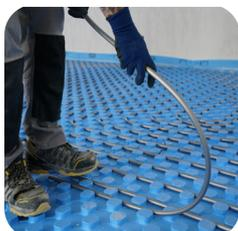
2. Los radios de curvatura deben ser amplios para evitar que la tensión provoque que el tubo se salga de los tochos.(tabla 2)
