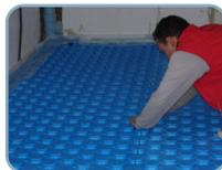
Debe comprobarse que la lámina de PE de la lira lateral queda por encima del elemento base una vez terminada la instalación.
