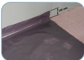
Es necesario la colocación de la hoja PE (barrera antivapor) en las zonas de forjado que estén en contacto directo con terreno natural o en forjados cuya parte inferior esté sometida a temperatura ambiente exterior, para evitar la condensación que se puede formar debajo del aislamiento del suelo radiante.
