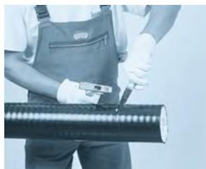
3.- Cortar el tubo de revestimiento a lo largo. Introducir la cuchilla a una profundidad máx. de 5 mm. Atención: ¡no dañar el tubo interior!
