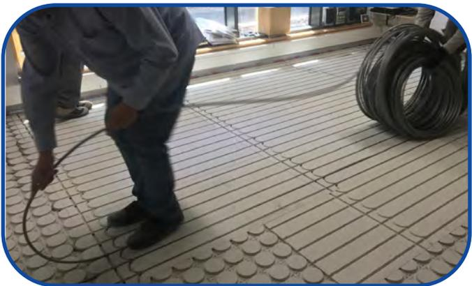
5.- Colocación tubo de los distintos circuitos.
