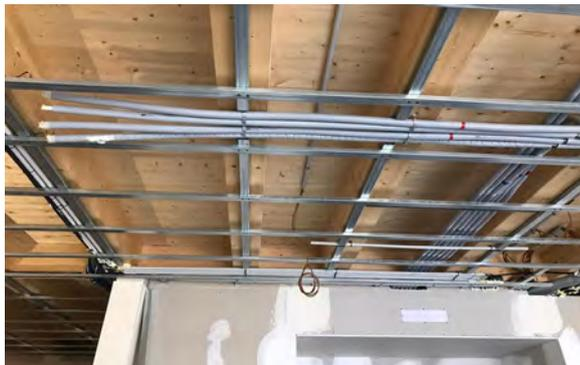
1. Preparar la perfilera metálica con una separación de 50cm o 60cm dependiendo de la orientación del panel, respetando las juntas de dilatación.
