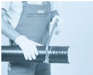
2.- Cortar el tubo de revestimiento con una sierra.
