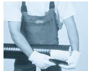
4.- Retirar el tubo de revestimiento cortado.
