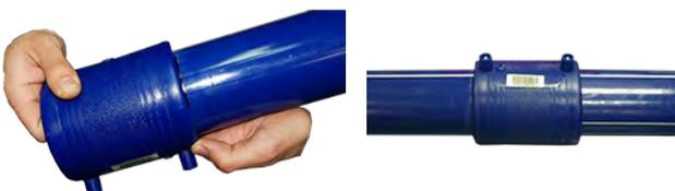
5.- Introduzir ambos os extremos dos tubos na peça a soldar até à linha de profundidade da soldadura marcada. O tubo tem ultrapassar a zona de resistência da peça no mínimo 10 mm .
