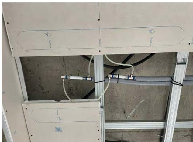
4. Cada panel de 2 x 1,2 m consta de 2 circuitos de 1 x 1,20m, y éstos a su vez pueden dividirse en dos circuitos de 0,5 x 1,2 m. La alimentación a los paneles con tubo de 20 podrá cubrir un máximo de 10-12 m<sup>2</sup> lo que equivale a un máximo de 5 paneles de 2x1,2m.
