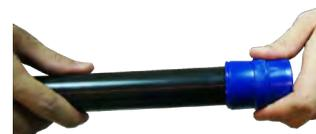
5.- Proceder à soldadura como indicado nas instruções de instalação por termofusão.
