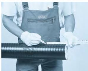
1.- Marcar en el tubo de revestimiento una distancia igual al diámetro del revestimiento D menos 30 mm del extremo del tubo.
