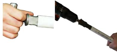
2. Calibrar y matar aristas y evitar rebabas que dañen las juntas al introducir el accesorio. Se puede calibrar manual o con maquina
