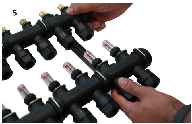
5.- Colocar el colector sobre los soportes.
