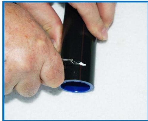
Levantar la capa exterior en todo el perímetro del tubo para poder soldar sobre el tubo interior.
