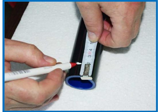
Dar un corte superficial sobre la capa exterior (sin dañar el tubo interior), en sentido longitudinal desde la marca hacia afuera y marcar el corte transversal.
