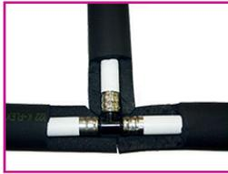
El espesor del aislamiento debe ser el suficiente para que al comprimirse absorba la dilatación del tubo
